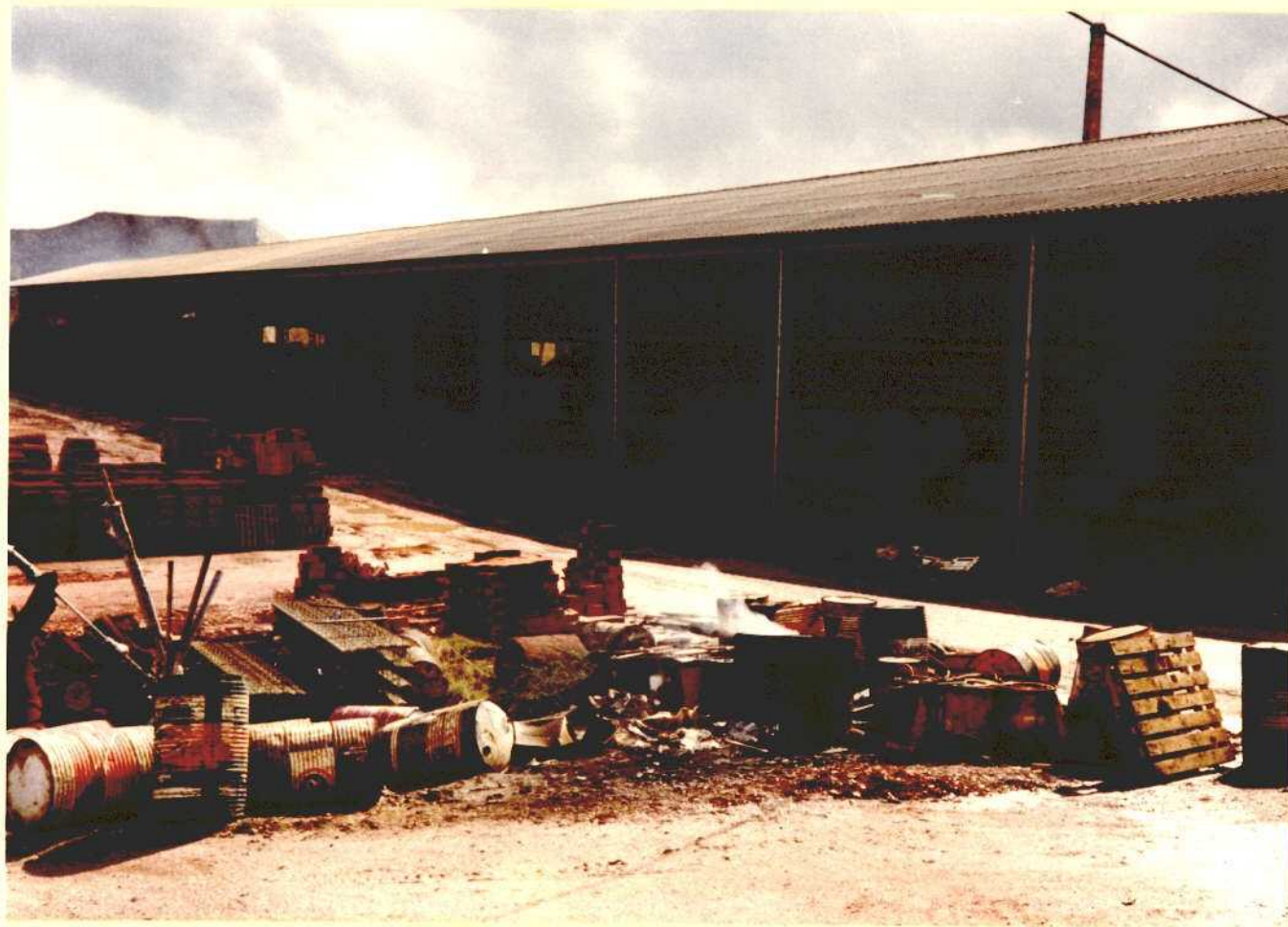
Fabrica de ladrillos situado junto a las explotaciones de arcillas.
